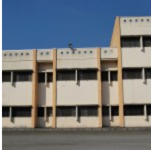
Edificio della sezione femminile
