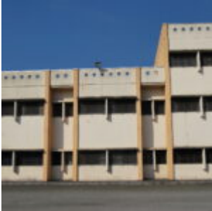
Edificio della sezione femminile
